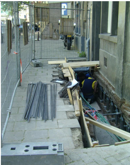
Nieuwezijds Voorburgwal 23 1012 RC Amsterdam Werkzaamheden plaatsing verstevigingsbalk fundering voorgevel augustus 2005
