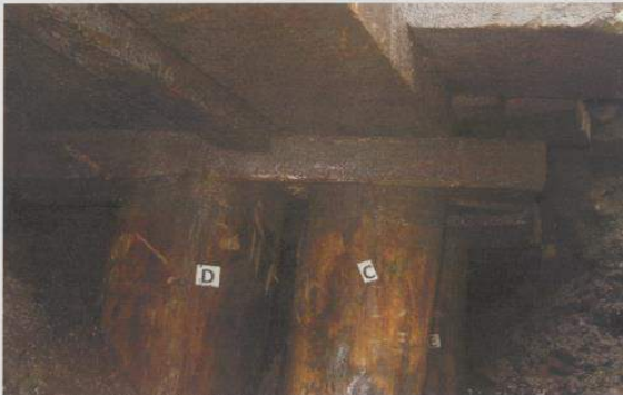
Langshout L1 en L2, schuifhout S1, kesp 2, paal C en D.
