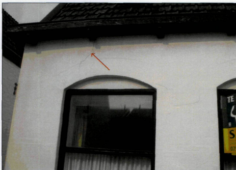
Foto 8: Doorgaande scheur vanaf de dakrand tot in de toog van de voorgevel van nr. 42.
