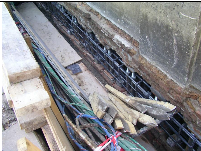
Nieuwezijds Voorburgwal 23 1012 RC Amsterdam Werkzaamheden plaatsing verstevigingsbalk fundering voorgevel augustus 2005
