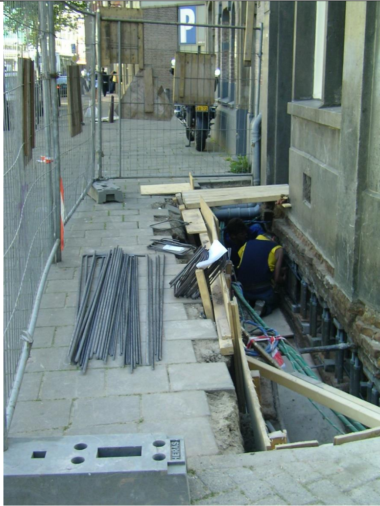
Nieuwezijds Voorburgwal 23 1012 RC Amsterdam Werkzaamheden plaatsing verstevigingsbalk fundering voorgevel augustus 2005
